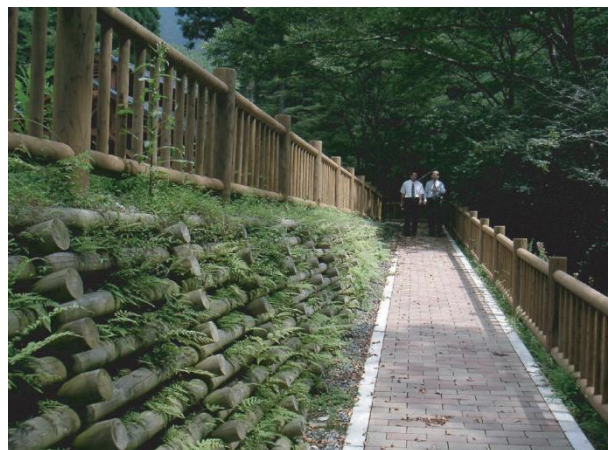
擁壁・木柵・木レンガの一体整備：高知県（H13）
