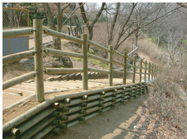
枚方市山田池公園補修工事 （階段・柵工）：大阪府（H15）
