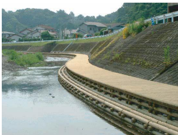
川づくり整備事業（多段積木工沈床工）：鹿児島県（H16）
