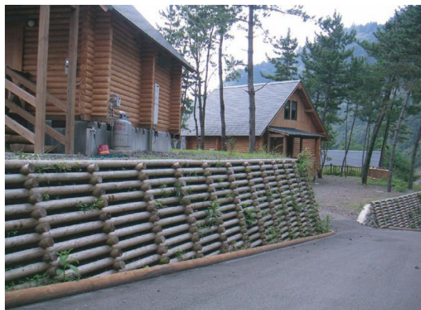
馬路村キャンプ場整備事業（擁壁工）：高知県（H13）
