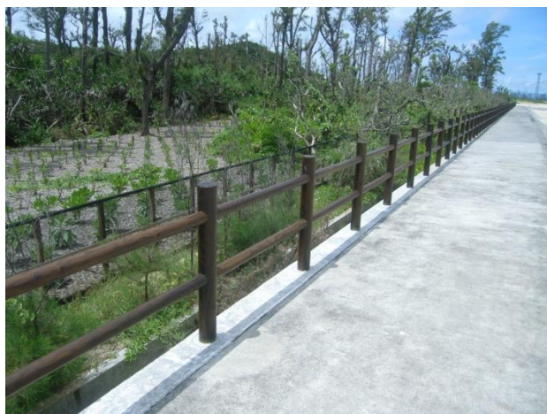
辺土名海岸防災林工事（転落防止柵）：国頭村（H22）
