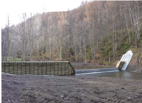
仁倉川治山工事（床固工）：北海道（H21）
