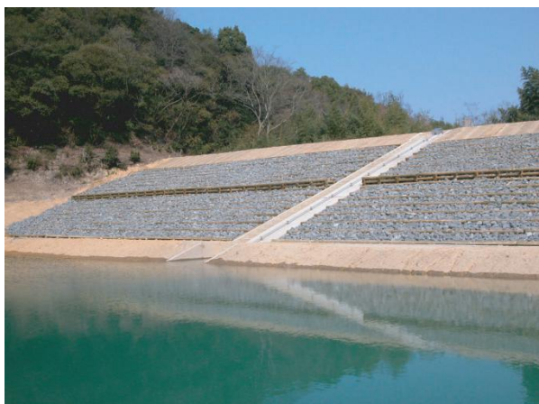
大河内池改修工事 （法枠護岸工・階段土留工）：大阪府（H18）
