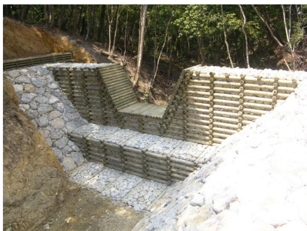
許田水源流域治山工事（谷止工）：名護市（H22）
