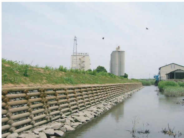
豊川放水路小坂井護岸補修工事（護岸工）：愛知県（H11）
