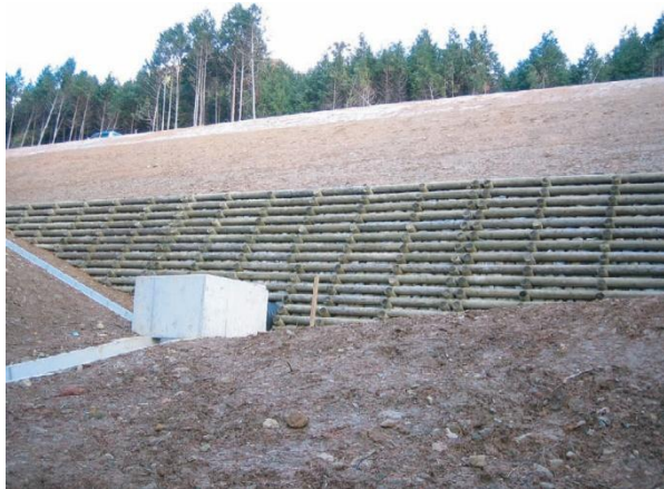
県道水上加美線新設工事（擁壁工）：兵庫県（H15）
