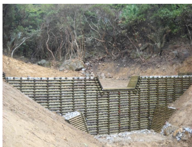
水源の里保全整備事業（谷止工）：伊平屋村（H22）
