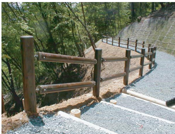
生活環境保全林整備事業（木柵工）：広島県（H15）
