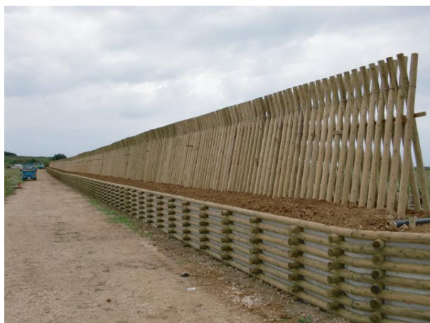
四志地区防災林整備事業（土留工）：栗国村（H19）
